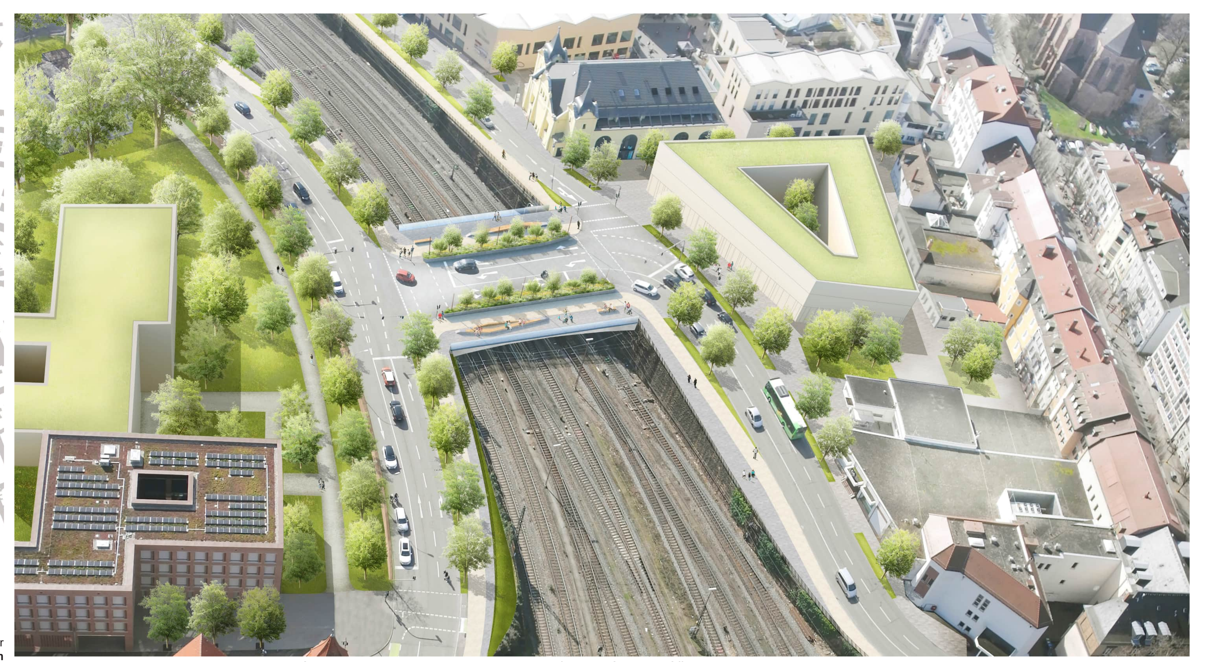
Die neue Brücke über den Bahngaben bildet das grüne Gelenk zwischen der Innenstadt und den östlich befindlichen Stadtteilen Offenburgs
