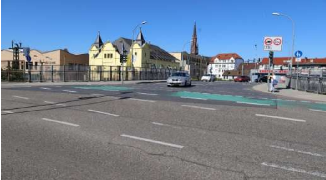
Abb.41 Unionbrücke, Blickrichtung Westen
