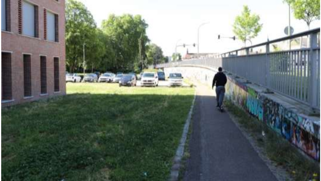
Abb. 44: Rampe Ostseite, von unten
