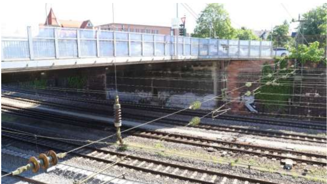
Abb.53: Ansicht der Brücke, östliches Widerlager
