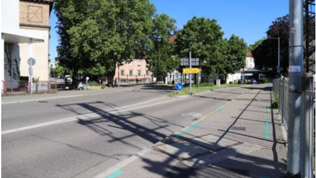
Abb.35: Unionrampe Blickrichtung Norden
