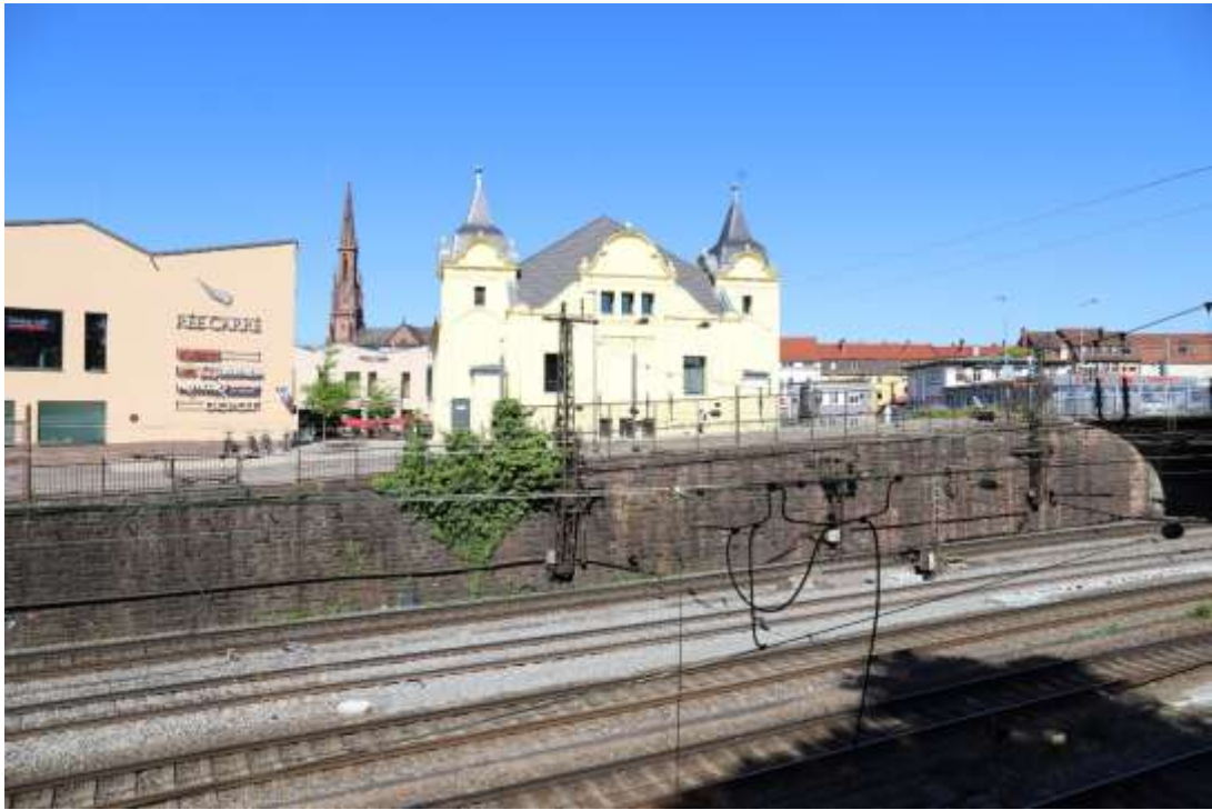
Abb 61: denkmalgeschützte Stützmauer Bahngraben Westseite
