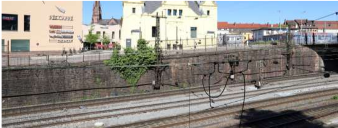
Abb.56: Rampe und Stützmauer Bahngraben Gustav-Rée-Anlage
