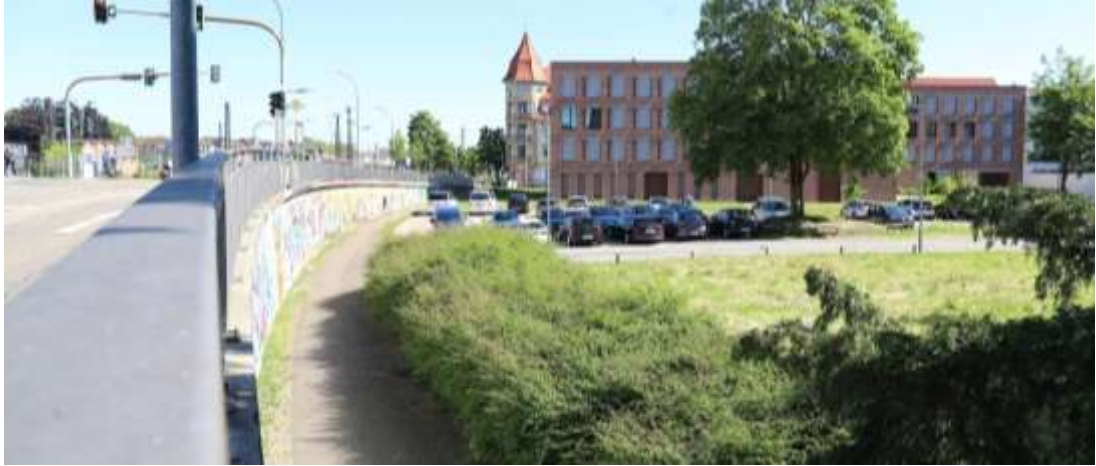
Abb.59: Rampe und Stützmauer Ostseite
