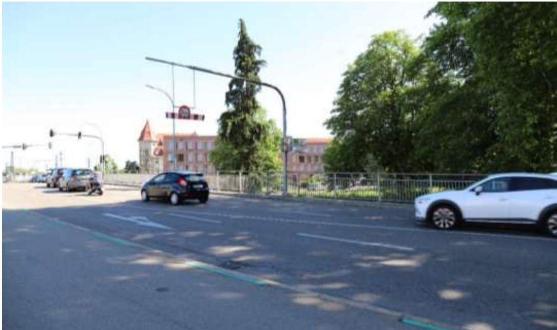
Abb.45: Rampe Ostseite, oben
