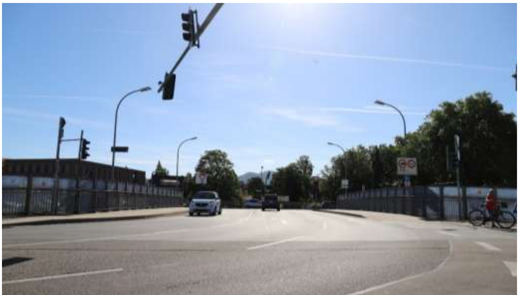
Abb.40: Unionbrücke, Blickrichtung Osten
