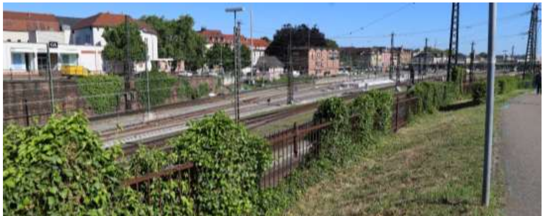
Abb.57: Rampe und Stützmauer Bahngraben Unionrampe
