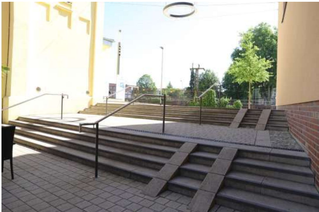
Abb.64: Treppenanlage zwischen Rée-Carré und Gustav-Rée-Anlage
