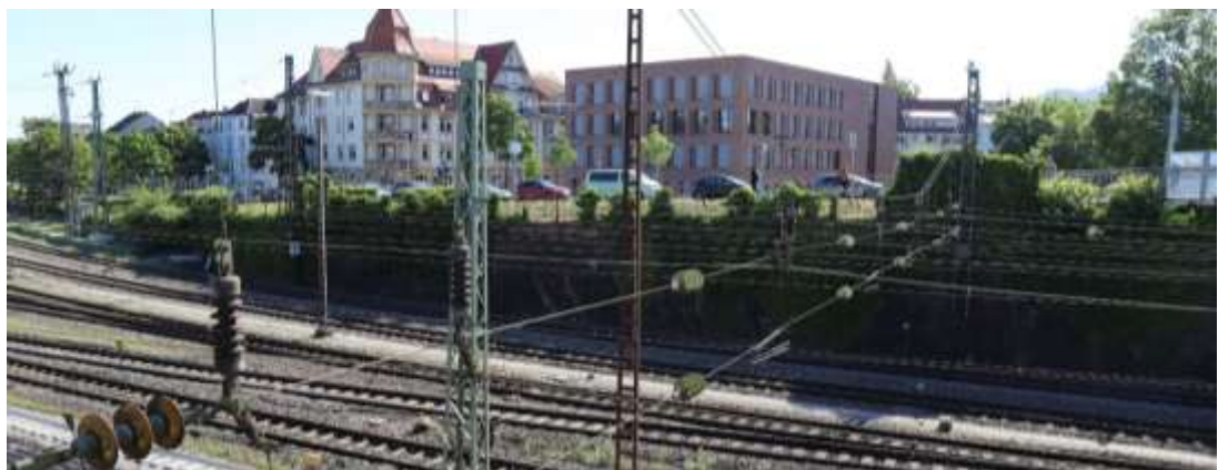
Abb.58: Rampe und Stützmauer Bahngraben Rammersweierstraße
